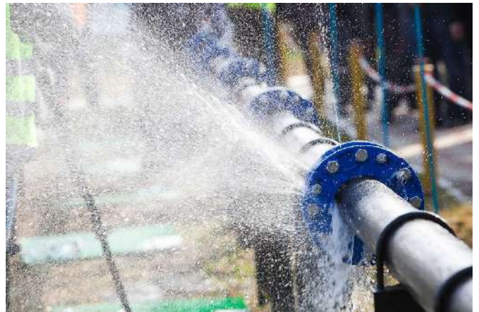
Abbildung: undichte Flanschverbindung ©pipicato - stock.adobe.com
